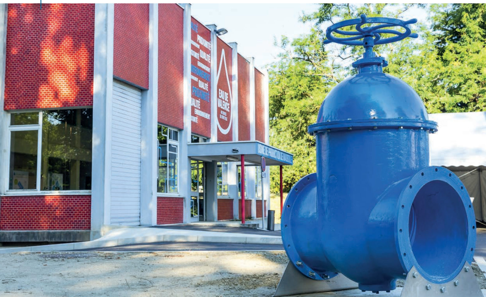
Usine de production de Mauboule à Valence
