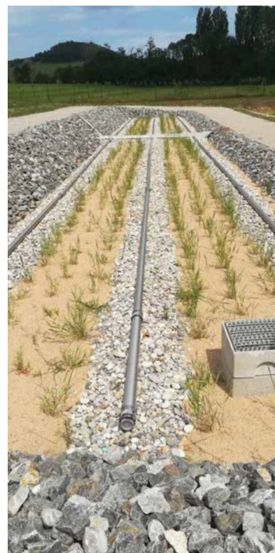
Station de traitement des eaux usées de Miribel.
