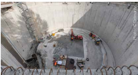
Travaux du bassin d'orage du lycée Camille Vernet à Valence.
