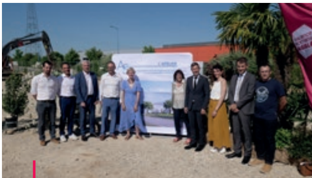
11 mai à Châteauneuf-sur-Isère, première pierre pour le nouveau bâtiment de L'Atelier, avec l'ambition d'atteindre les 350 salariés d'ici à 5 ans.
