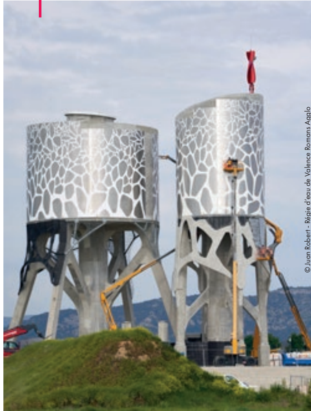
Mai, au plateau Lautagne à Valence, pose de l'habillage architectural sur le nouveau château d'eau pour fondre l'ouvrage dans le ciel ! Bientôt, pose d'une centaine de nichoirs à oiseaux.
