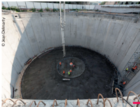
GÉANT ! 30 MÈTRES DE DIAMÈTRE ET 14 DE PROFONDEUR POUR LE BASSIN D'ORAGE EN CONSTRUCTION À L'ÉCOLE CAMILLE VERNET À VALENCE.
