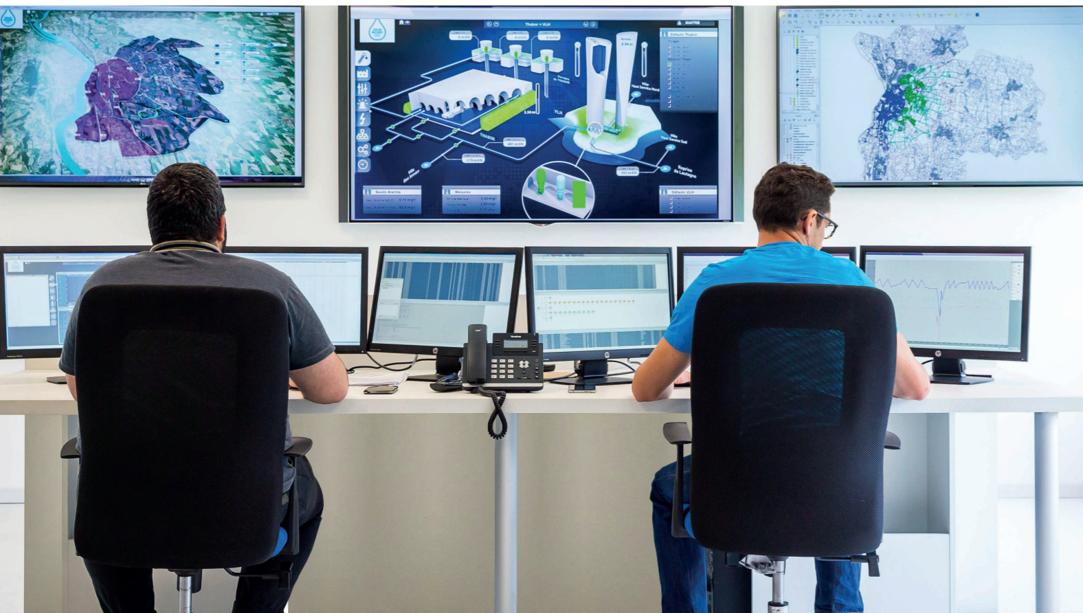
▼ Centre de pilotage - Régie Eau de Valence Romans Agglo
