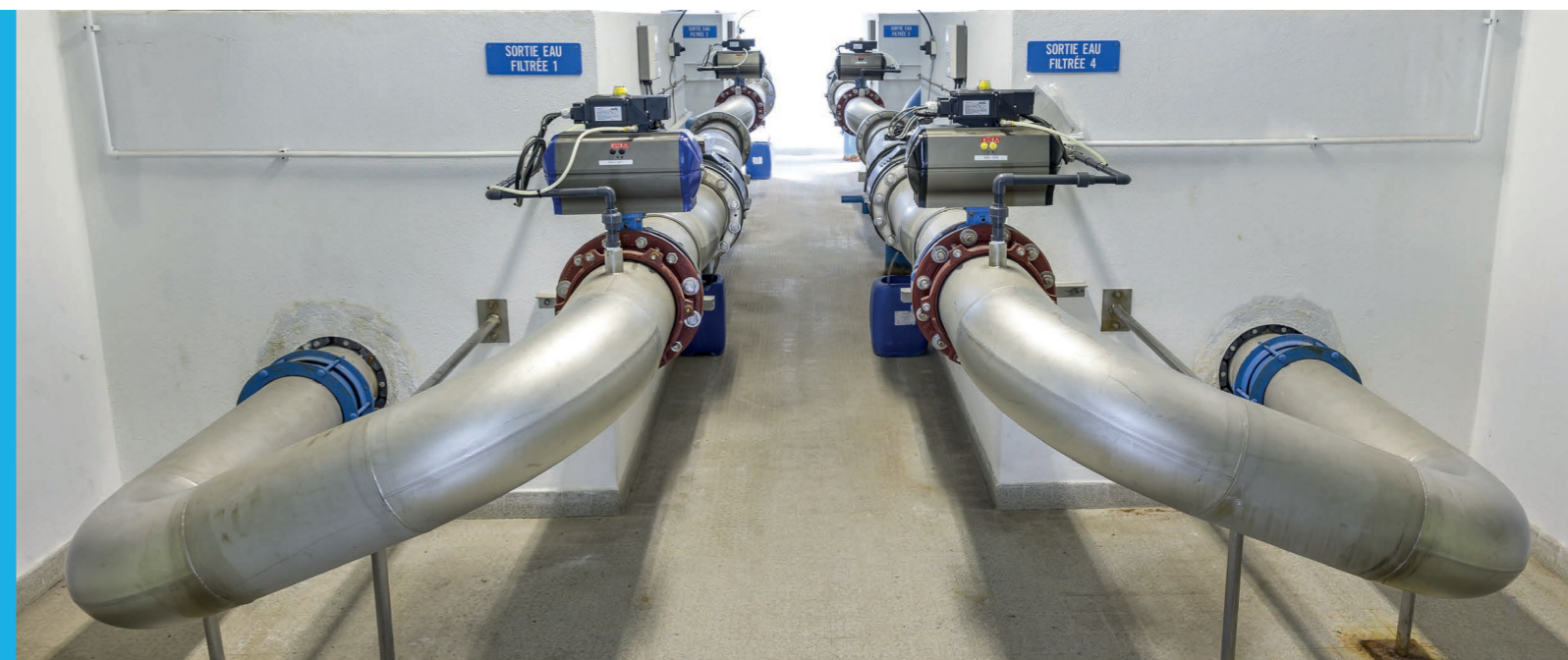
▼ Régulation de la filtration - Usine de Mauboule à Valence
