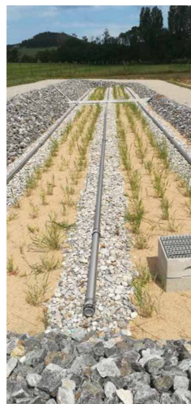
Station de traitement des eaux usées de Miribel.
