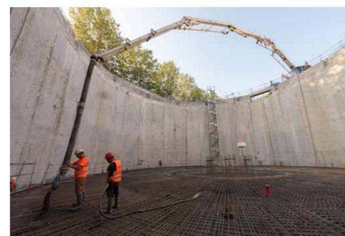
Construction du bassin d'orage de 7 000 m 3 à Valence
