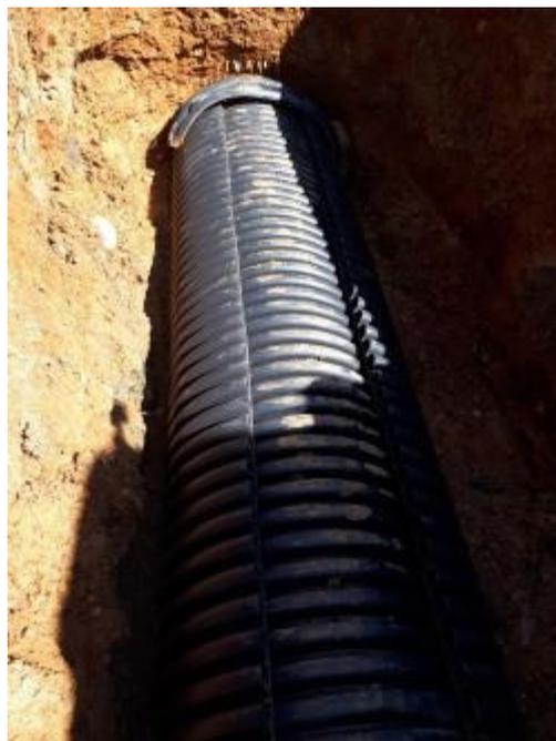
La canalisation est ainsi reconstituée en perdant un minimum de diamètre. Le béton est déversé sur les coté et le dessus de la coquille.
