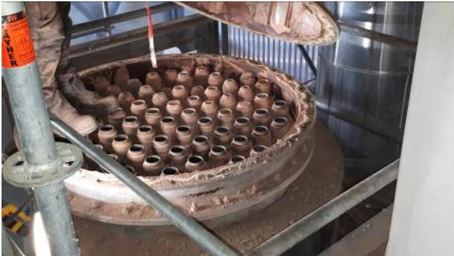
Démontage de la partie supérieure de l'échangeur avant remplacement des tubes de fumées
