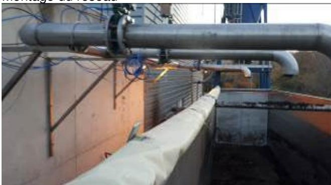
Canalisation en attente de traçage et calorifugeage
