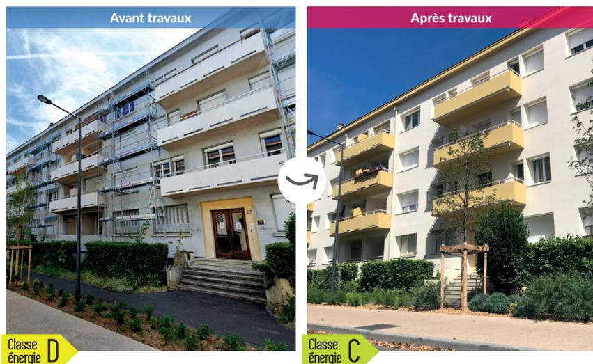
Afin de réduire la facture d'énergie et de bénéficier d'un meilleur confort de vie, les copropriétaires du Saint-Martin (26 logements sur 4 étages) ont décidé de lancer des travaux de rénovation : isolation par l'extérieur, remplacement des persiennes par des volets roulants, remplacement de la porte d'entrée, isolation de la dalle béton et installation d'une VMC autoréglable.
